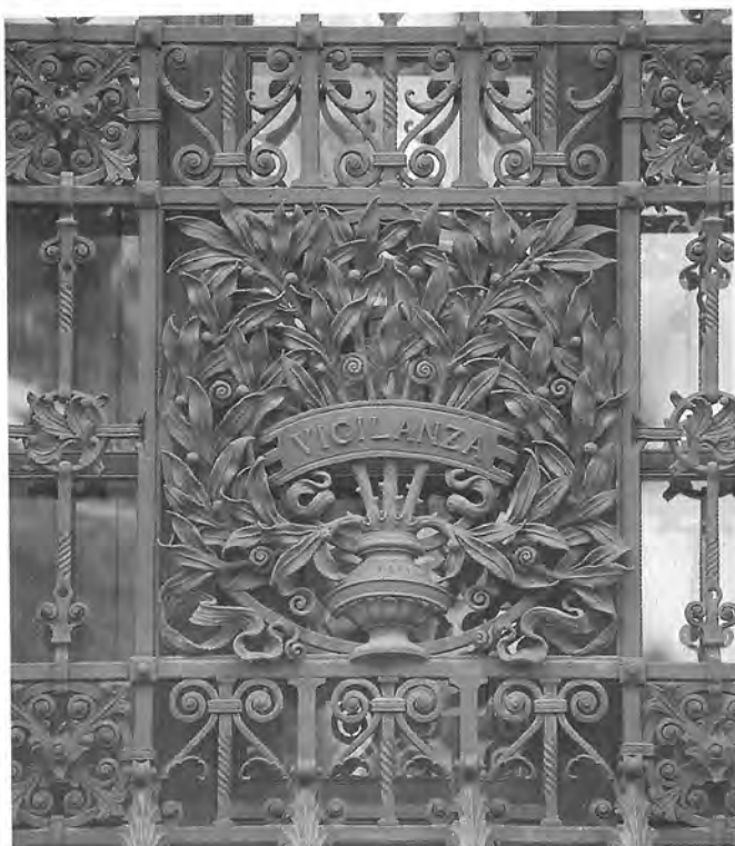
Inferriata di una delle finestre al piano terra, a sinistra dell'entrata principale, col malto "Vigilanza".
