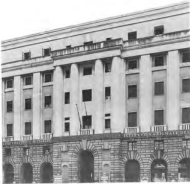
Facciata della Camera di Commercio progettata negli anni trenta da Gino Miozzo, con echi monumentalistici, benché altre sue opere si ispirano all'architettura razionalista.
