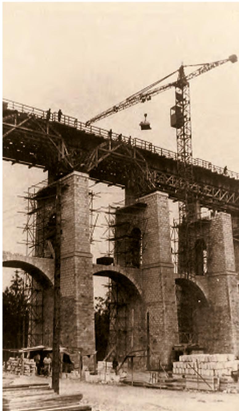
Les reconstructions après la Seconde Guerre mondiale (Archives départementales de Haute-Marne, cliché P. Huberdaux)
