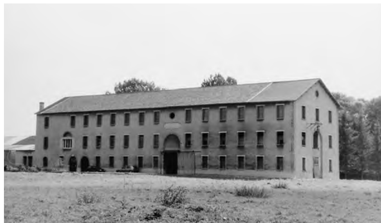
Chaintrix (Marne) a été une grande papeterie au XIX e siècle avant de devenir une usine de produits chimiques (DRAC Champagne-Ardenne)
