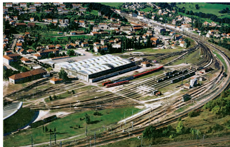
Vue du dépôt de Culmont-Chalindrey (Ville de Chalindrey)
