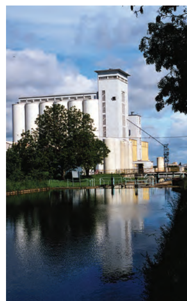
Le cours du canal est ponctué de silos céréaliers (cliché L. Hervé)
