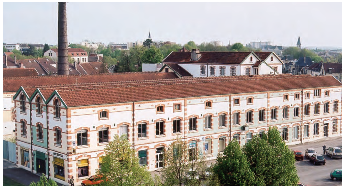
Les vestiges actuels de l'usine Tréfousse, devenus centre commercial (cliché T. Guyenet)
