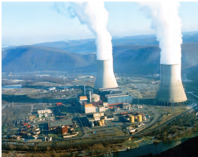
La centrale de Chooz B et ses deux tours de refroidissement, de 170 et 172 m (collection Centre nucléaire de production d'électricité de Chooz)
