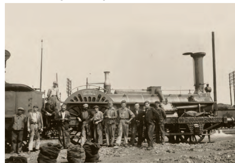
Locomotive Crampton, machine historique aux roues de 2,40 m de diamètre (collection J.-P. Muller)
