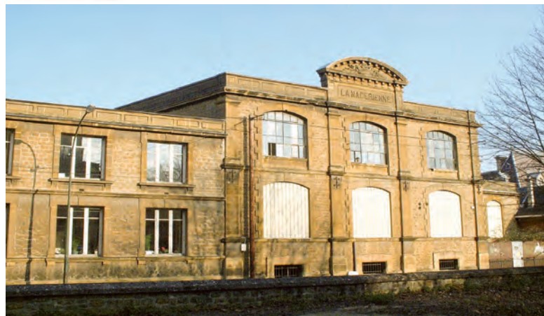
État actuel de la façade principale du grand atelier de mécanique (cliché R. Colinet)
