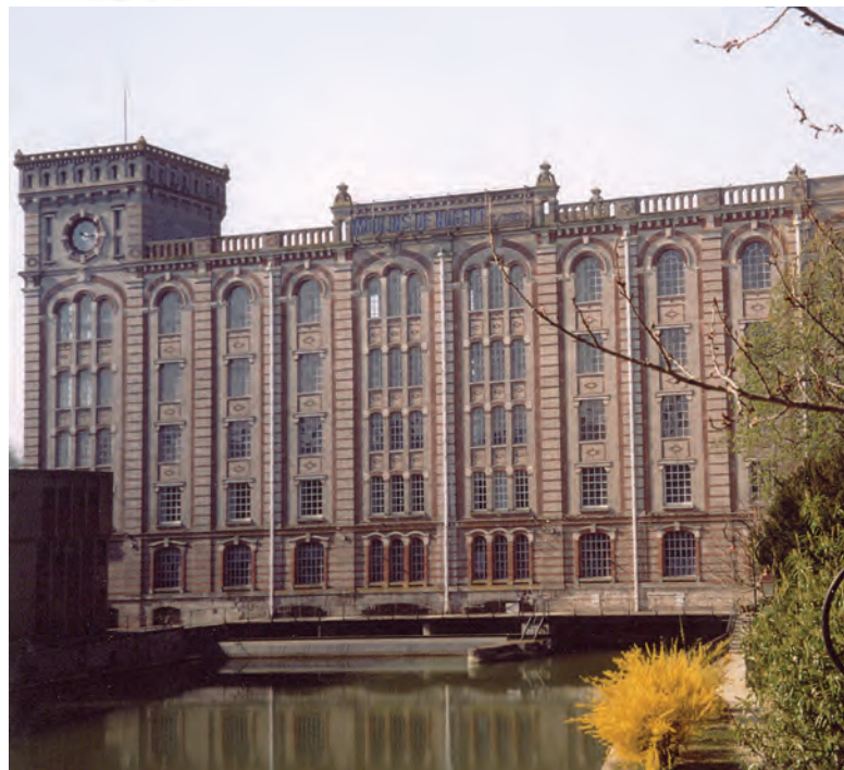
L'architecture des Grands Moulins rappelle celle des édifices classiques (cliché C. Werny)
