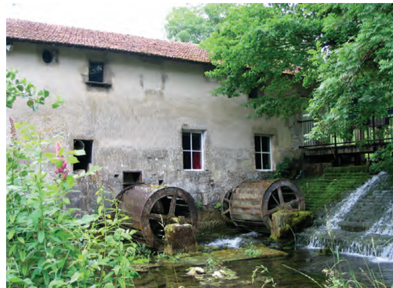
Les roues à augets, alimentées par les eaux de la Source Bleue, actionnaient les maillets de la papeterie (cliché F. Michelot)
