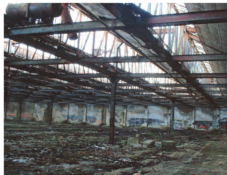
Intérieur du « nouvel atelier de mécanique » avec sa charpente métallique de type Eiffel, aujourd'hui (cliché J.-M. Duquénois)
