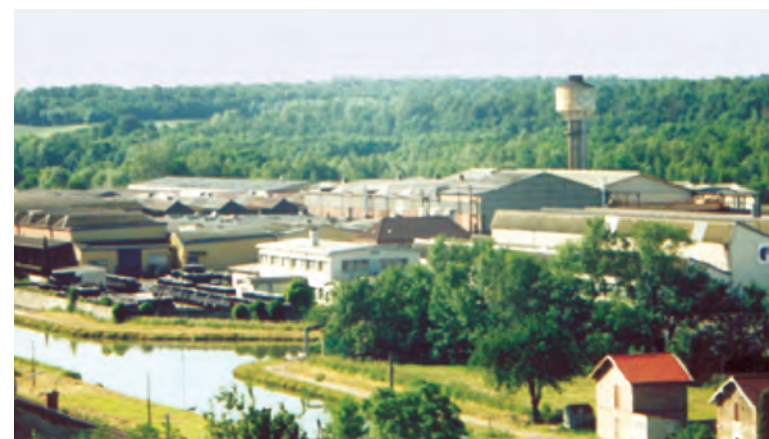
La tréfilerie. Elle fut construite en 1936 sur l'emplacement de la première forge Baudesson (cliché E. Thiry)
