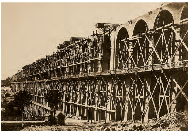
Le viaduc en construction (Archives départementales de Haute-Marne, cliché P. Huberdaux)
