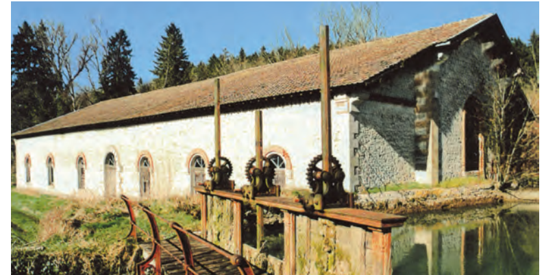
Cirey-sur-Blaise : ancien bâtiment du haut-fourneau avec ses aménagements hydrauliques (DRAC Champagne-Ardenne)
