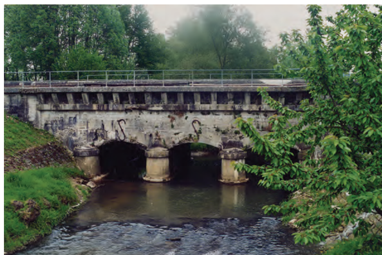
Près de Vitry, à Brusson, le canal de la Marne au Rhin passe au-dessus de la Bruxenelle par un pont canal, véritable ouvrage d'art (cliché L. Hervé)
