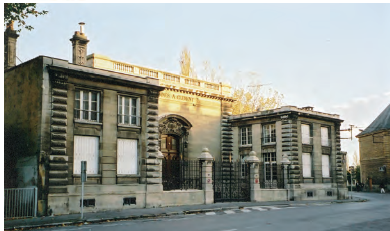
Façade sur rue de la centrale Mazarin (cliché R. Colinet)
