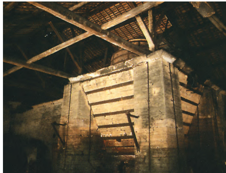
Le haut-fourneau de Dommartin reste le témoignage le plus spectaculaire de la grande époque de la métallurgie haut-marnaise (DRAC Champagne-Ardenne)
