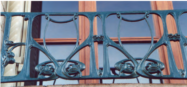
Appui de fenêtre Guimard, à Saint-Dizier (cliché E. Thiry)
