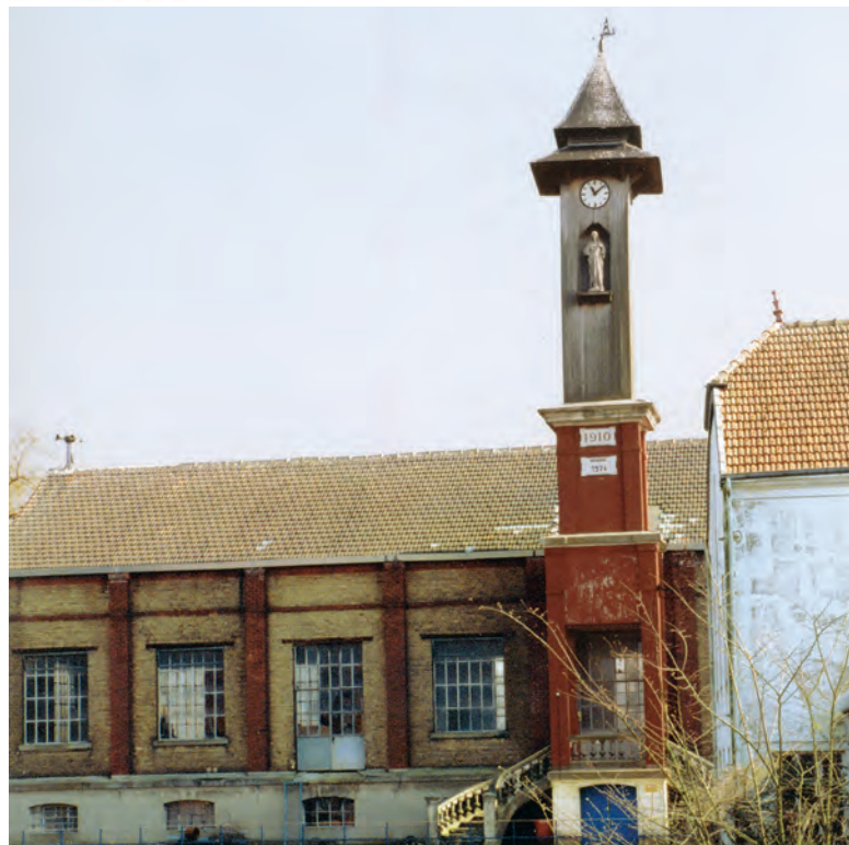
Le clocheton du bâtiment de la turbine de l'usine de Brevilly, avec la statue de Saint-Éloi, patron des forgerons (cliché A. Renard)
