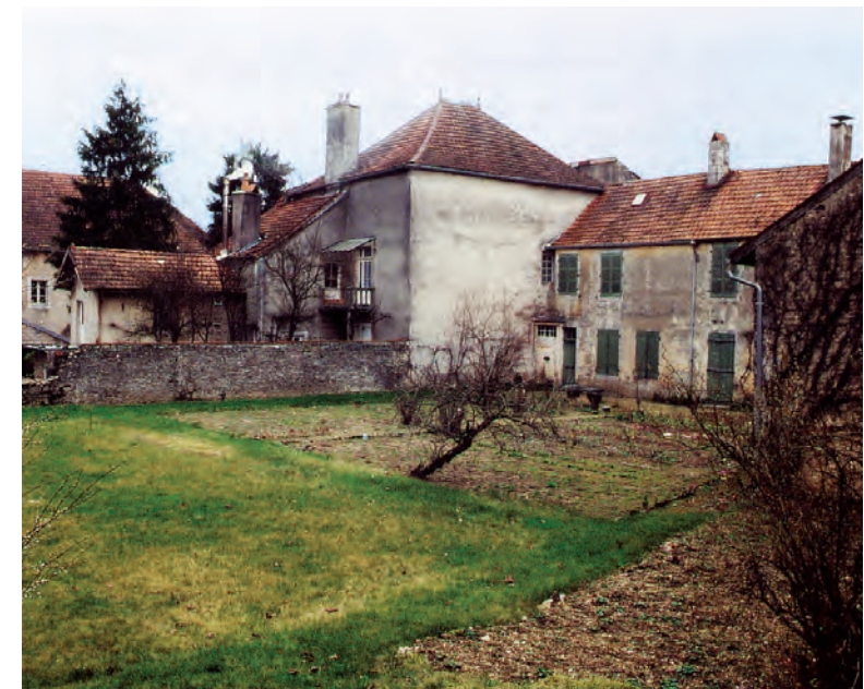
Giey-sur-Aujon : bâtiments de la porcelainerie, état actuel (cliché F. Michelot)
