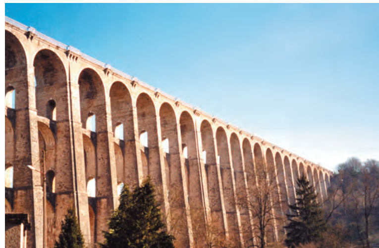
Vue actuelle du viaduc de Chaumont (cliché J.-N. Guyenet)
