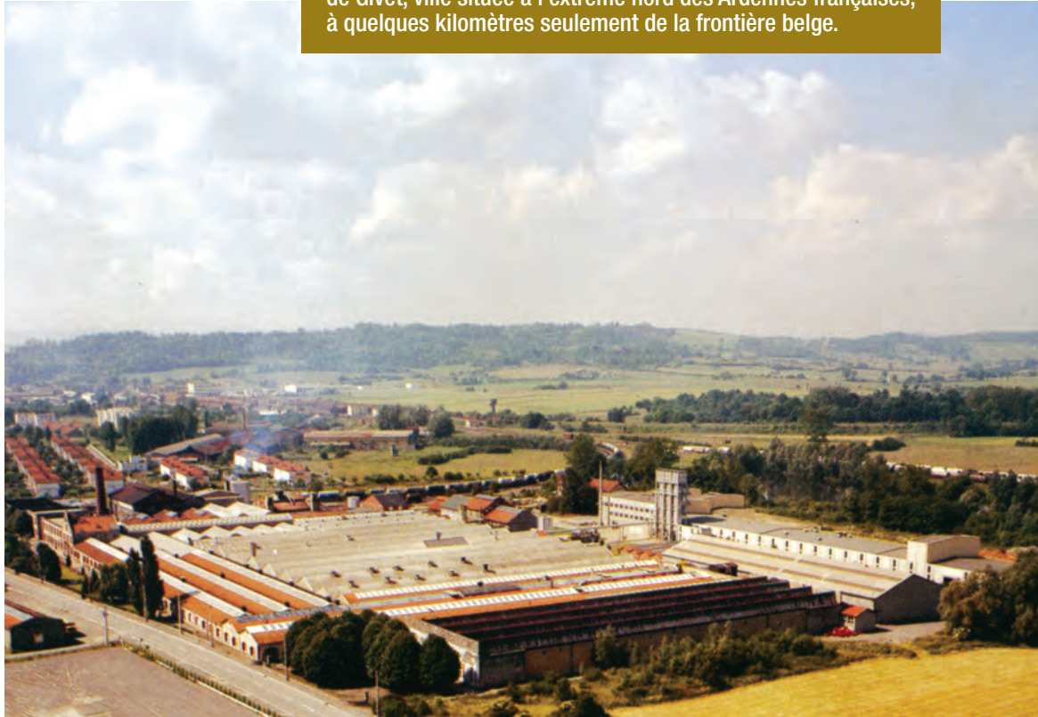
Vue générale du site Cellatex en 1985 (collection particulière)
