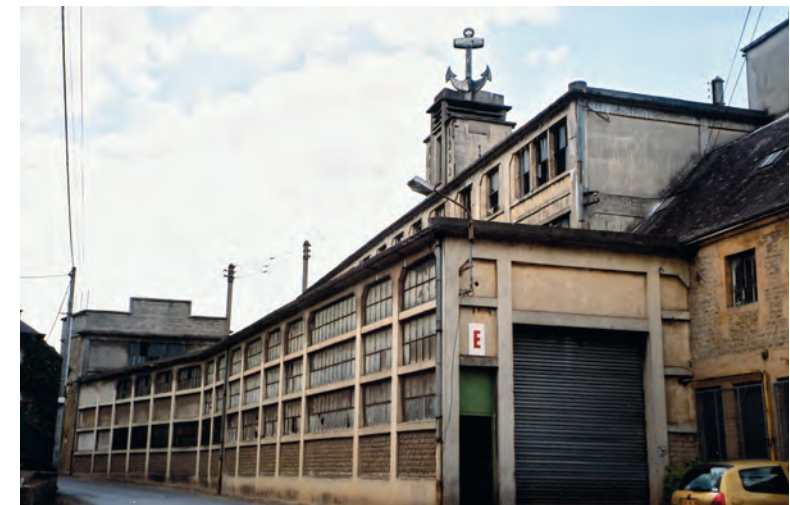
Façade de l'usine aujourd'hui, surmontée de l'ancre de marine (cliché R. Colinet)
