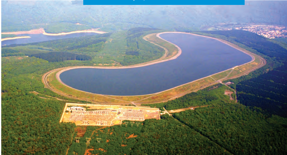
Vue sur le bassin supérieur et le bassin inférieur de la centrale de Saint-Nicolas-les-Mazures (STEP de Saint-Nicolas-les-Mazures)
