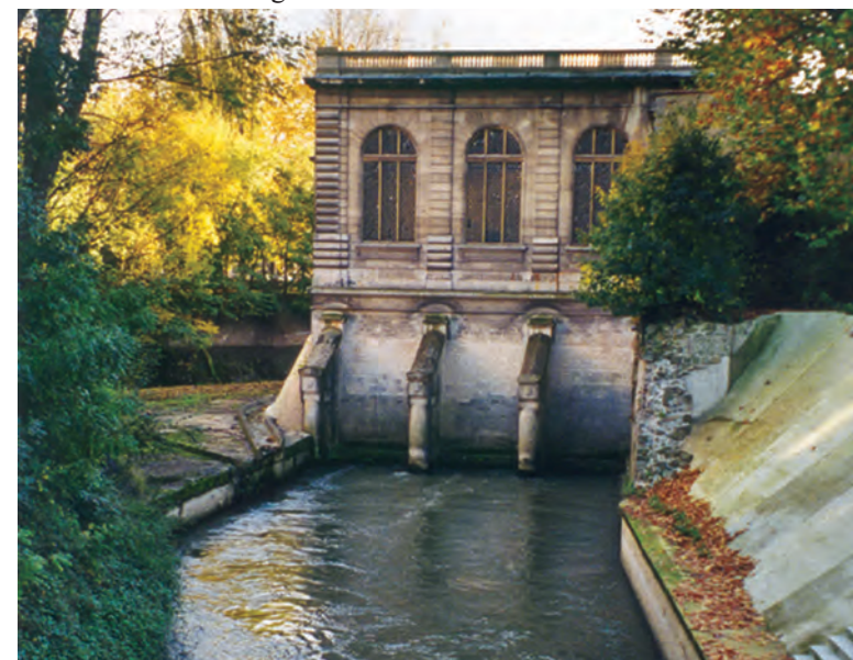
Vue sur le canal de fuite de la centrale Mazarin (cliché R. Colinet)
