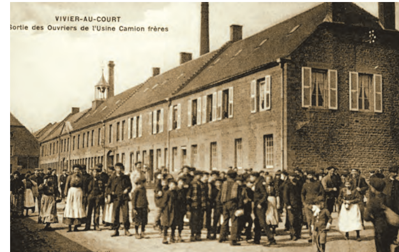
Sortie de l'usine vers 1930 (collection particulière)
