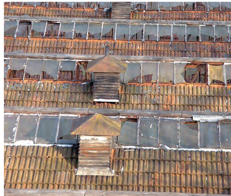
État actuel du toit en sheds du « nouvel atelier de mécanique » (cliché J.-M. Duquénois)
