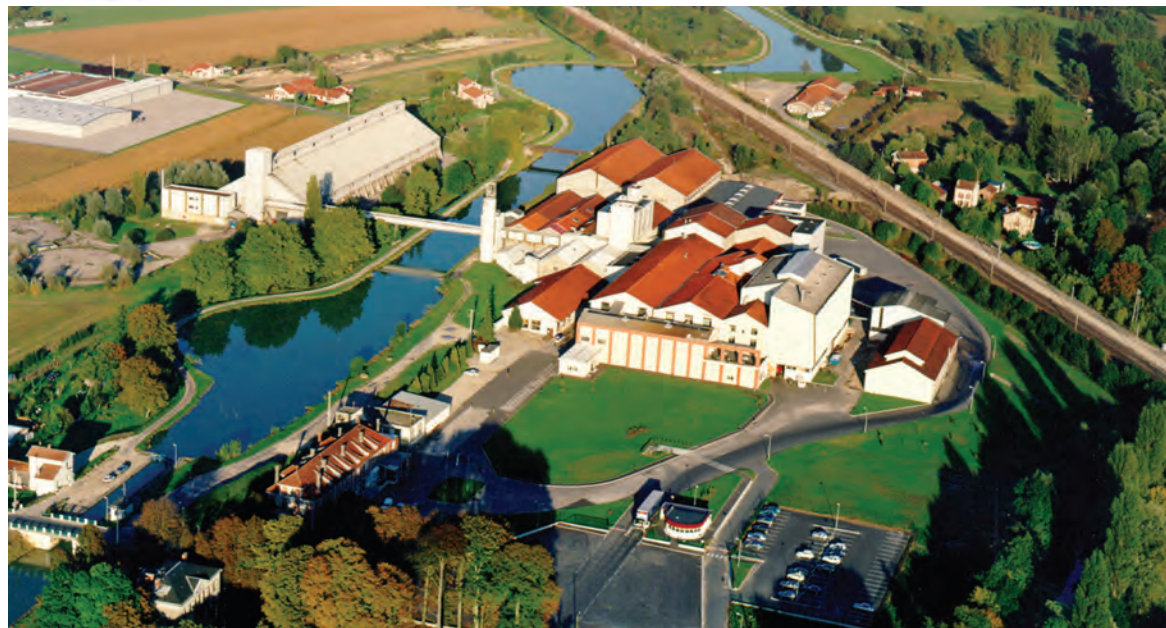
Vue oblique de la sucrerie de Sermaize, vouée aujourd'hui au conditionnement (Sucre Union Conditionnement)
