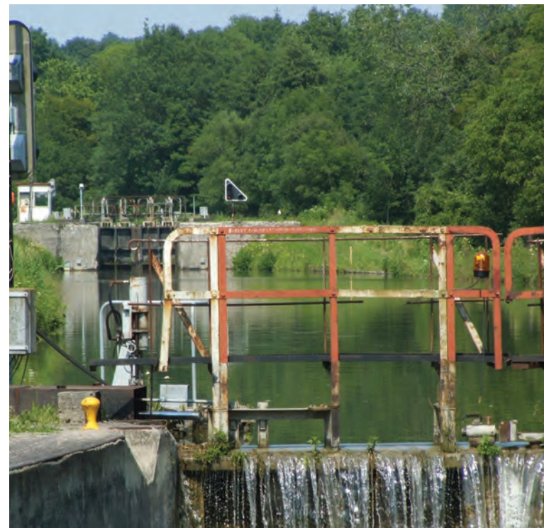
Deux écluses en enfilade à Montgon (cliché J.-F. Saint-Bastien)
