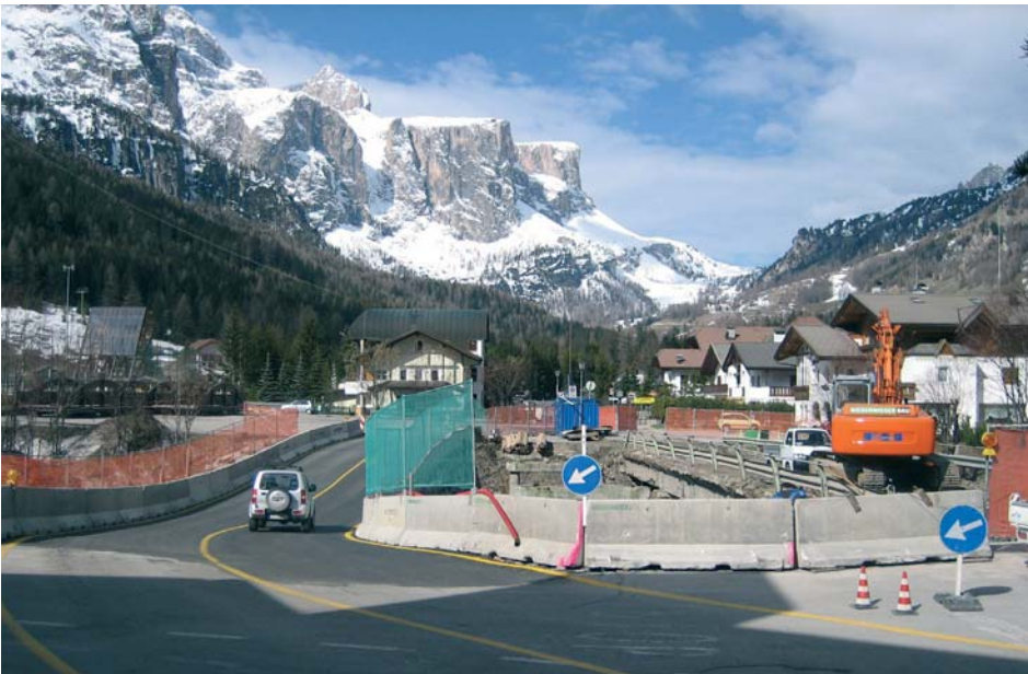
Die Arbeiten des Landes werden bis Anfang November andauern
