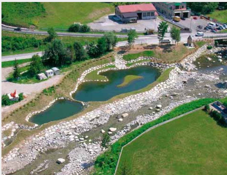
Foto servizio Bacini Montani PAT a lavori appena terminati
