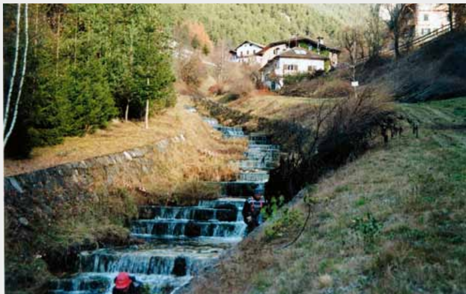
La situazione dopo l'intervento
