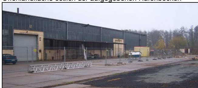
Gewerbebrache südöstlich des ehem. Hafens
