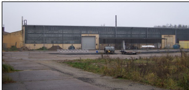
Gewerbebrache südöstlich des ehem. Hafens
