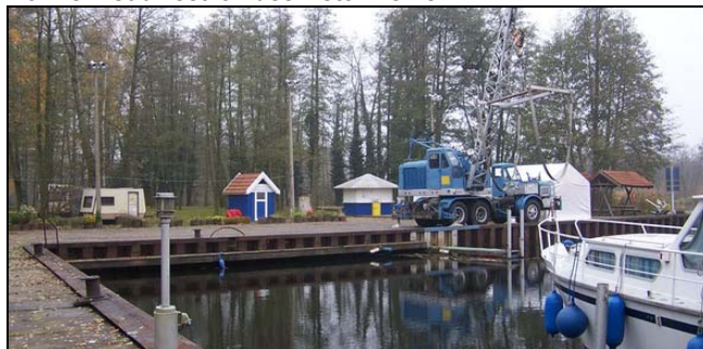
Hafenbecken westlich des Ziegeleistichs Blick nach Süd
