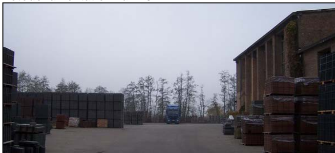
Betonwerk nordwestlich Ziegeleistich Blick Richtung Havel
