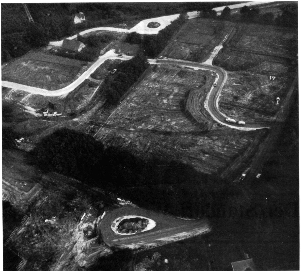
15. September 1981: Erdarbeiten für den Neubau in Wechloy (Foto: Woljke (freigegeben von der Bezirksregierung Weser-Ems am 29.9.81, Nr. 39/13/15))
