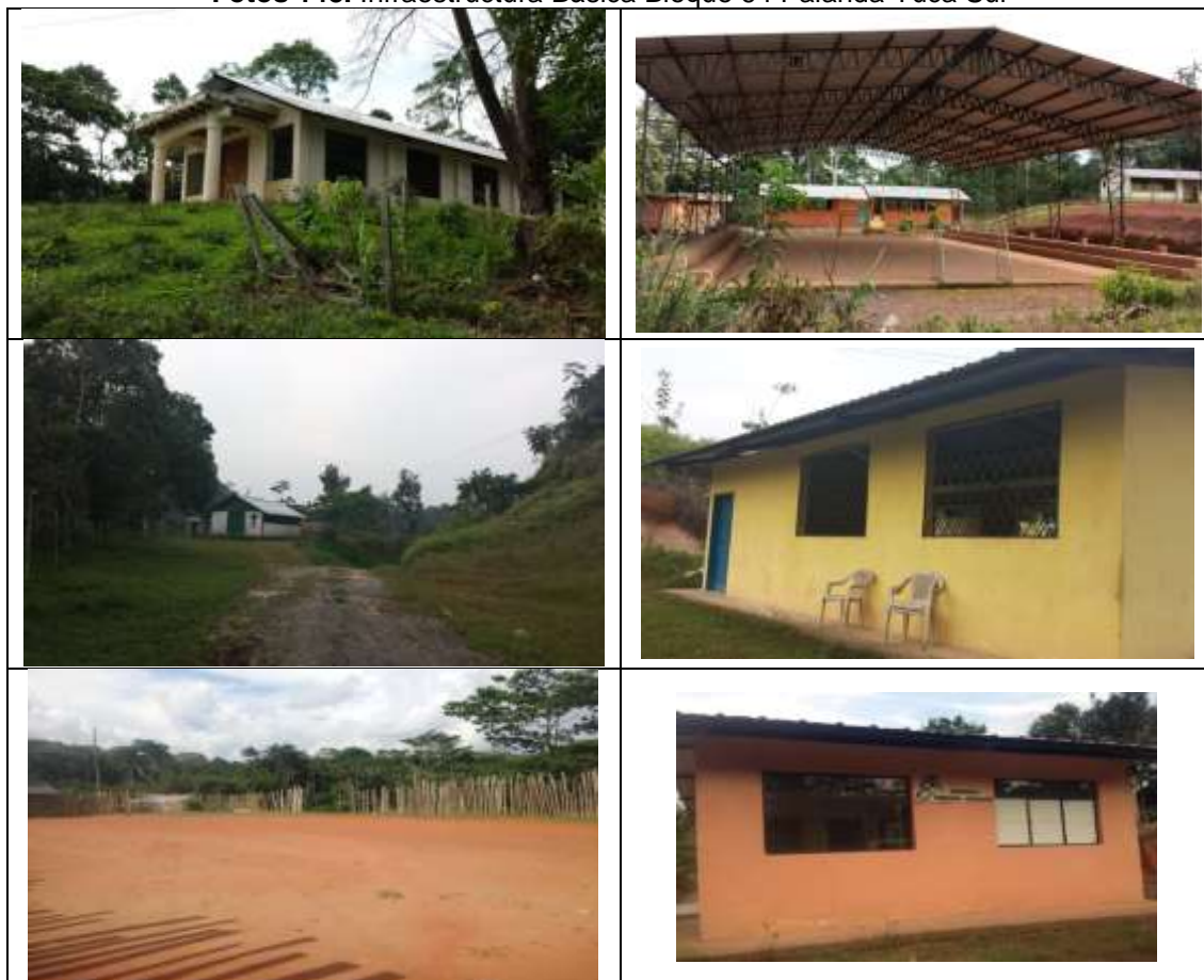
Fotos 148. Infraestructura Básica Bloque 64 Palanda Yuca Sur
