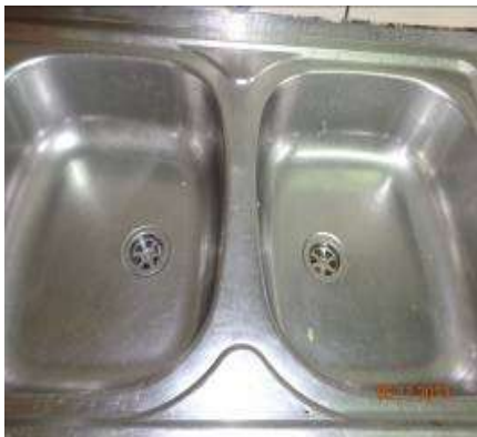
Lavabo con rejilla para retención de sólidos en la cocina del campamento.
