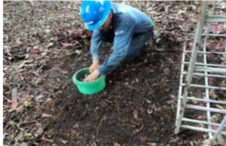
Foto 2. Retiro del “tops oil” para su posterior uso en la re vegetación.
