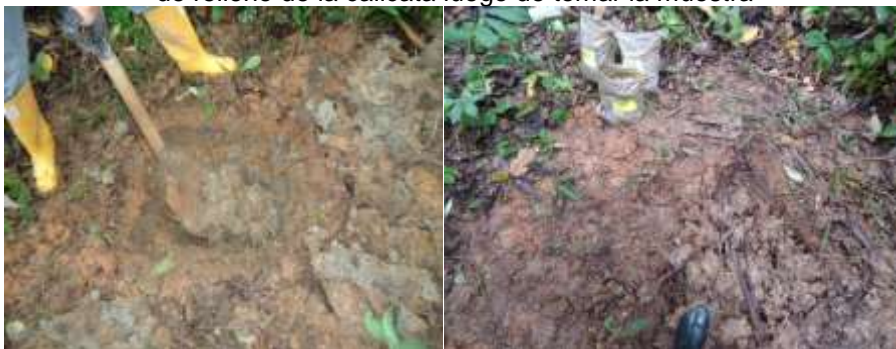
Fotos 59. Izquierda, proceso de realizar la calicata de la muestra FEB38S. Derecha, proceso de relleno de la calicata luego de tomar la muestra
