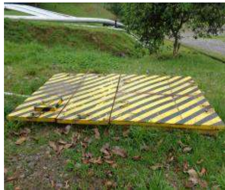
Trampa de grasas para las aguas grises de la cocina.
