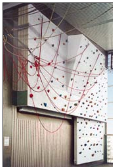
B Teilabgelassener Einstiegsbereich, alle Sicherungsseile sind nach oben weggezogen.
