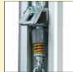
Netz entspannt – Feder sichtbar
