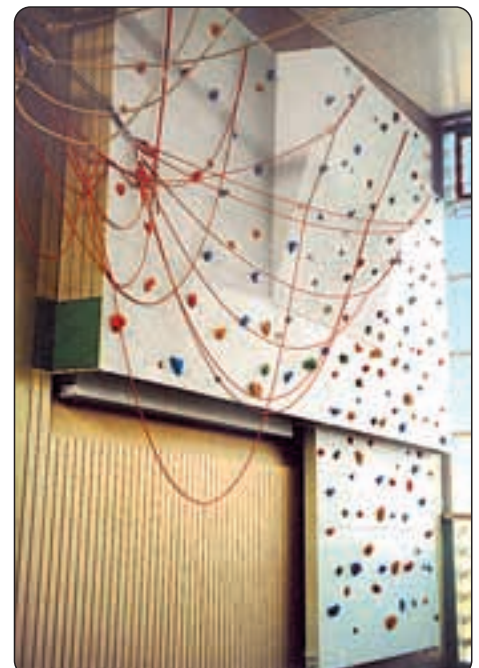
B Teilabgelassener Einstiegsbereich, alle Sicherheitsseile sind nach oben weggezogen.
