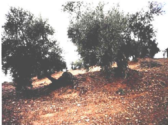
Εικόνα 4 Έντονα διαβρωμένη περιοχή.
