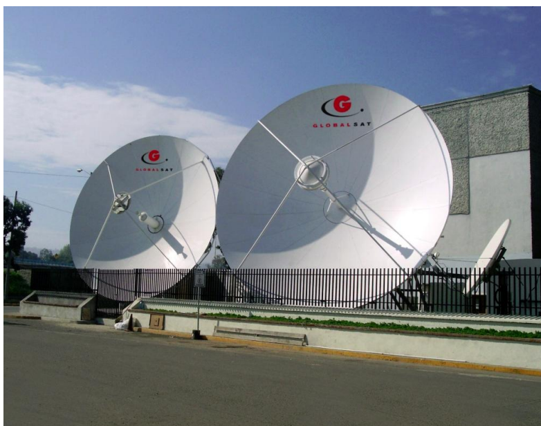
Figura 3-13: Telepuerto en Banda C y Ku.
