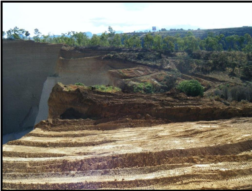
Figura 20. Descapote del banco de producción
