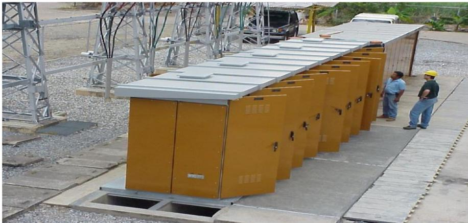
**Imagen que muestra la inspección visual a una subestación compacta a la intemperie.**
