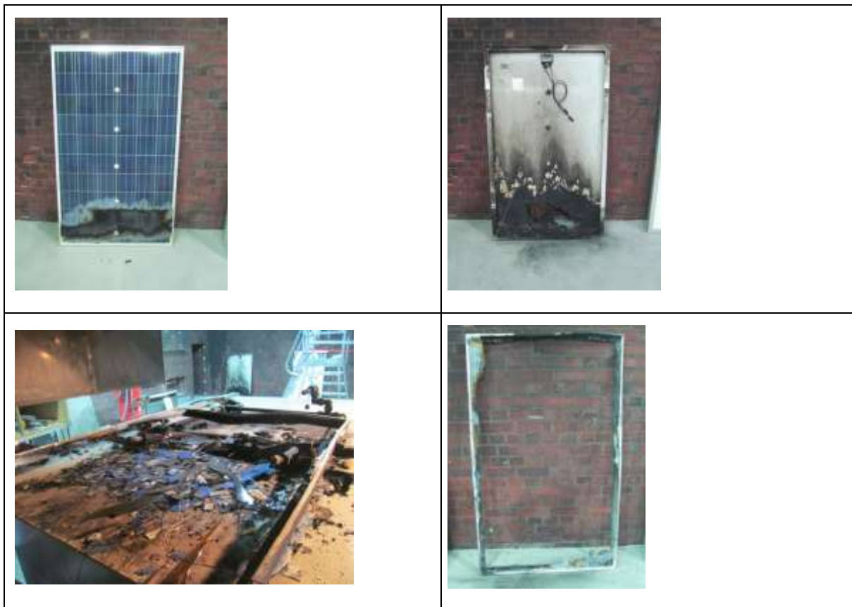
Bild 4-37: Schadensausmaß bei c-Si bei 25 kW Brennerleistung (oben) und 150 kW (unten)
