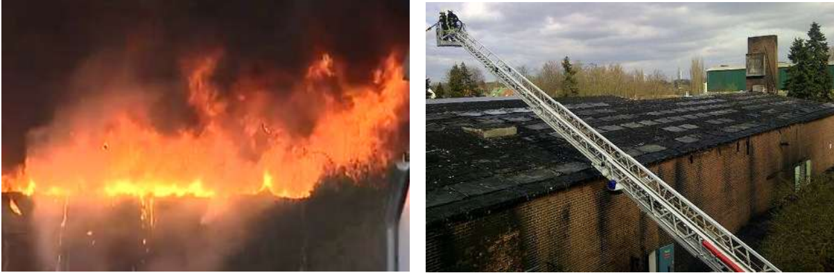
Bild 3-34: Lichtbogenereignis in einer dach-aufgeständerten PV-Anlage. Links: Bitumen Dachbahnen brennen unter starker Rauchentwicklung und tropfen brennend ab. Rechts: Glücklicherweise konnte das Gebäude gerettet werden, Fotos: Freiwillige Feuerwehr Goch
