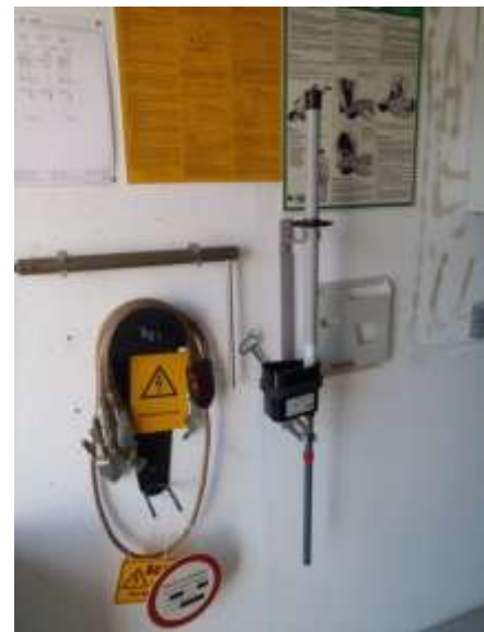
Bild 5-42: Erd- und Kurzschluss-Kit für den Transformator
