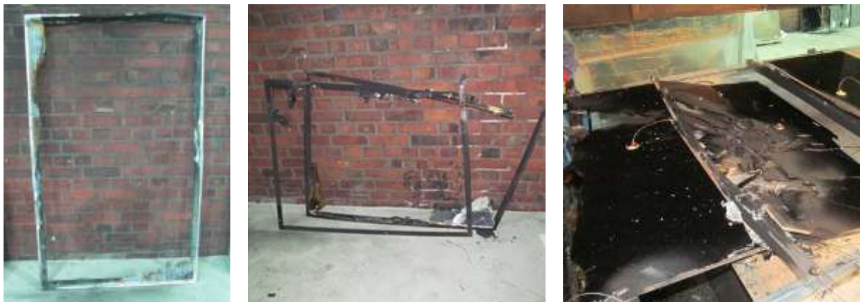
Bild 3-3: Beschädigungen nach Beanspruchung mit 150 kW Brennerleistung, links: c-Si, Mitte: CIS (quer angeordnet), Rechts: CdTe (quer angeordnet)
