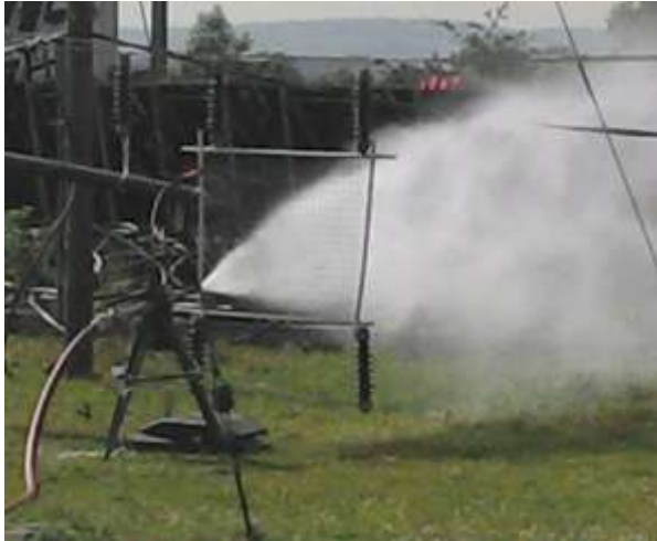
Bild 4-17: Messung von Ableitströmen beim Löschen unter Spannung stehender elektrischer Anlagen. Versuche auf dem Gelände der OVAG in 2014, Kooperationsprojekt OVAG und vfdb
