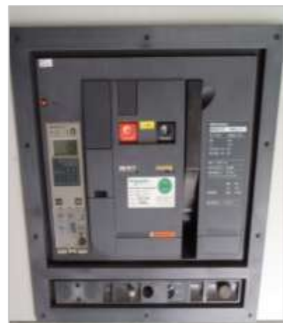
Bild 5-40: Lasttrennschalter
