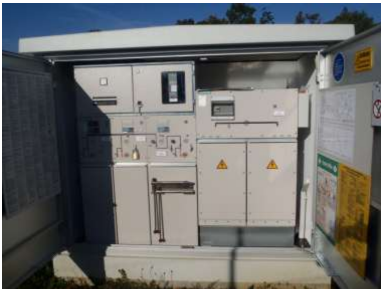
Bild 5-41: Mittelspannungsschaltstation
