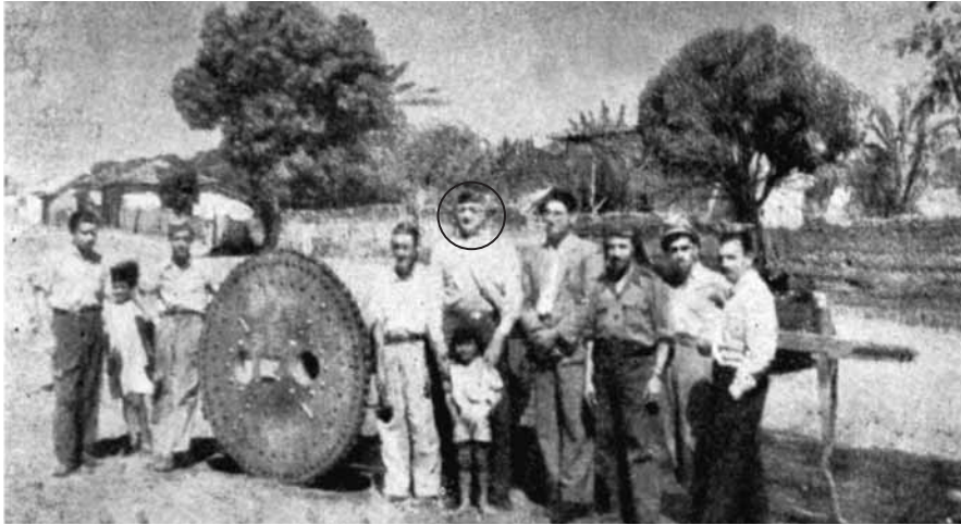
General Polli Coelho (C) em frente a uma fábrica de carros de bois com rodas ferradas, em Planaltina – DF. Foto: Arquivo Público do DF.
