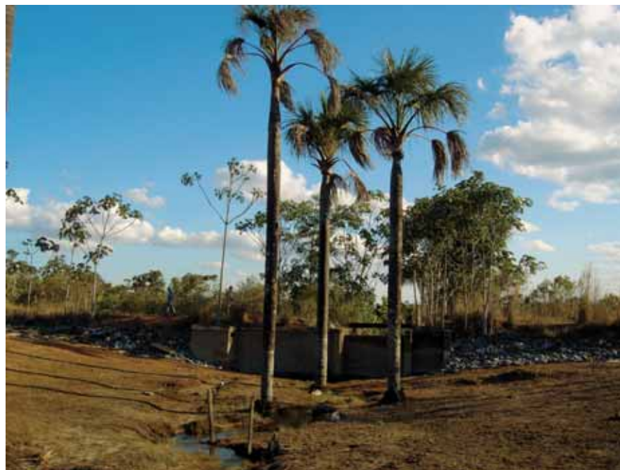
Captação do Córrego Casarra (desativada). Foto: Carlos Terrana.
