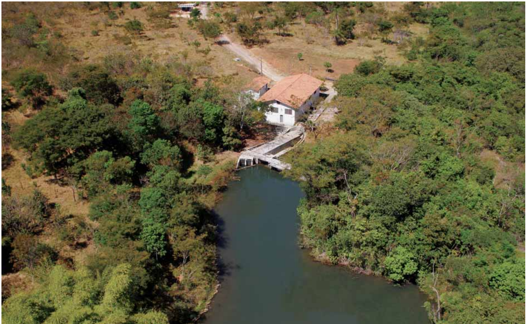
Captação do Córrego Fumal. Foto: Carlos Terrana.
