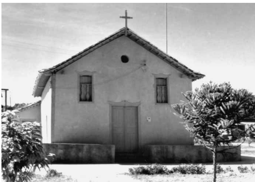
Igreja de São Sebastião, 1975. Foto: Arquivo Público do DF.
