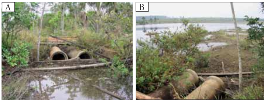
Figura 2 – Nível da água da Lagoa Bonita ao final do período seco. A – Situação em 29/08/2003; B – Situação em 13/10/2003. Os tubos que aparecem nas fotos são a conexão com o Córrego Mestre d'Armas. Na época de chuvas o nível atinge o topo da tábua usada na barragem, havendo então sangramento da água excedente para o córrego. Fotos: Letícia Moraes.
