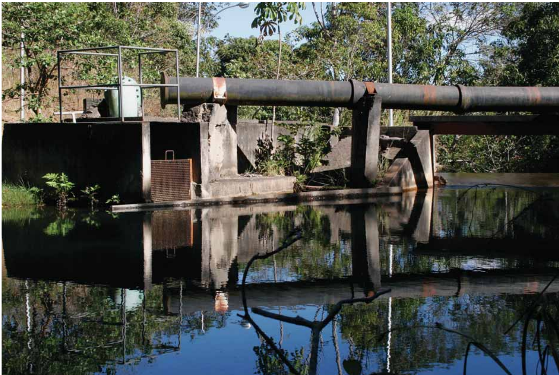
Captação do Córrego Cascarra (desativada). Foto: Carlos Terrana.
