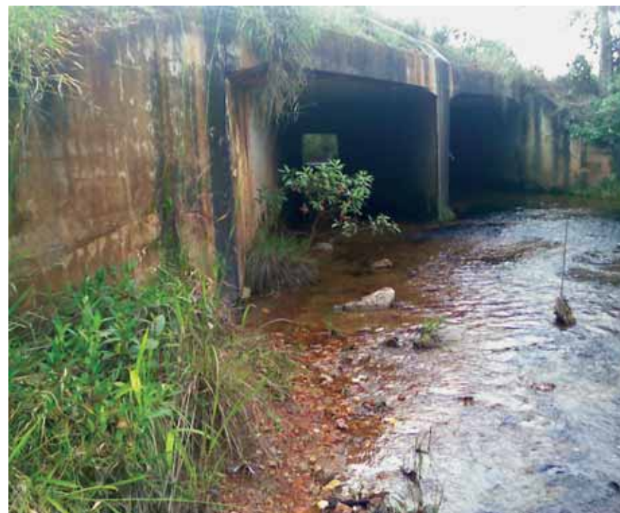
Figura 4 – Exemplo de passagem subterrânea de fauna na rodovia GO-239.
