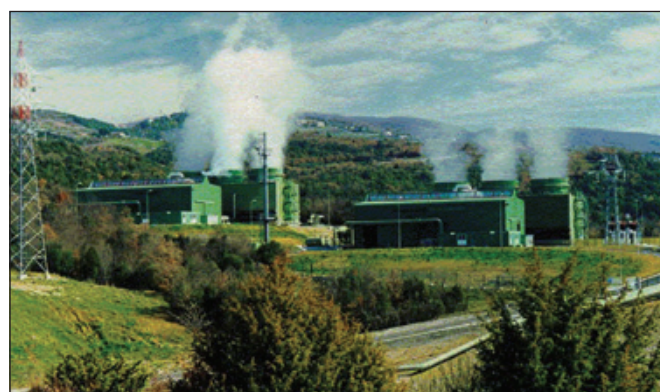
Figura 6: Central geotérmica en Carbolí (Italia) (Fuente: Enel Green Power)
