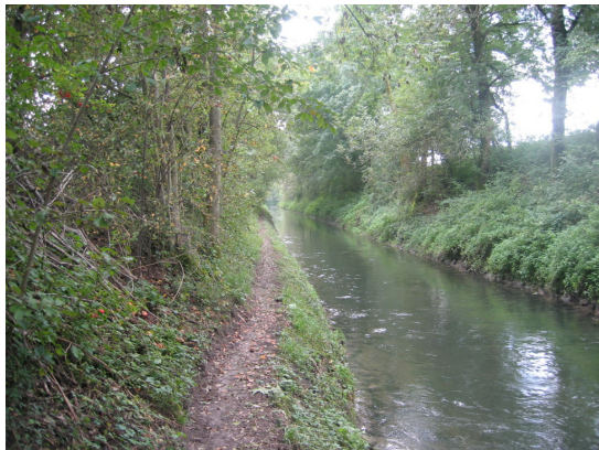
Abbildung 19: Ehbach – gleichförmiges Gerinne mit trapezförmigem Profil.
