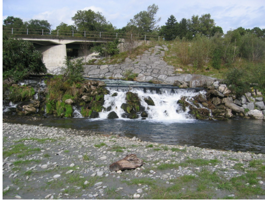
Abbildung 4: Mündung Saarkanal mit Absturz von ca. 3 m (Beckenpass auf dem Bild nicht sichtbar).
