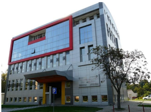
Слика 1 – Изглед објекта
