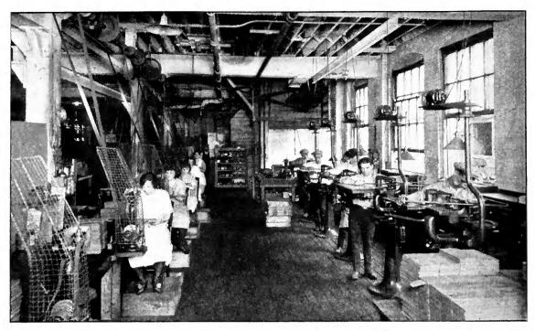
ENGRAVING AND FINISHING PANELS FOR FOUR-TUBE RECEIVERS
