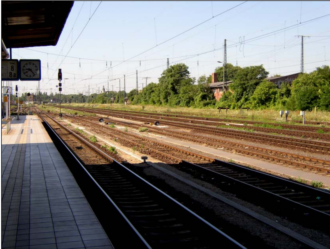
Abb.3: Blick von Gleis 8 des Hbf. Magdeburg nach Südwesten. Der unterschiedliche Aufwuchs auf den Flächen bzw. zwischen den Gleisen siegelt die heutige Nutzungsintensität gut wider. Der Gehölzstreifen dürfte weitgehend auf spontane Ansiedlung zurückzuführen sein.
