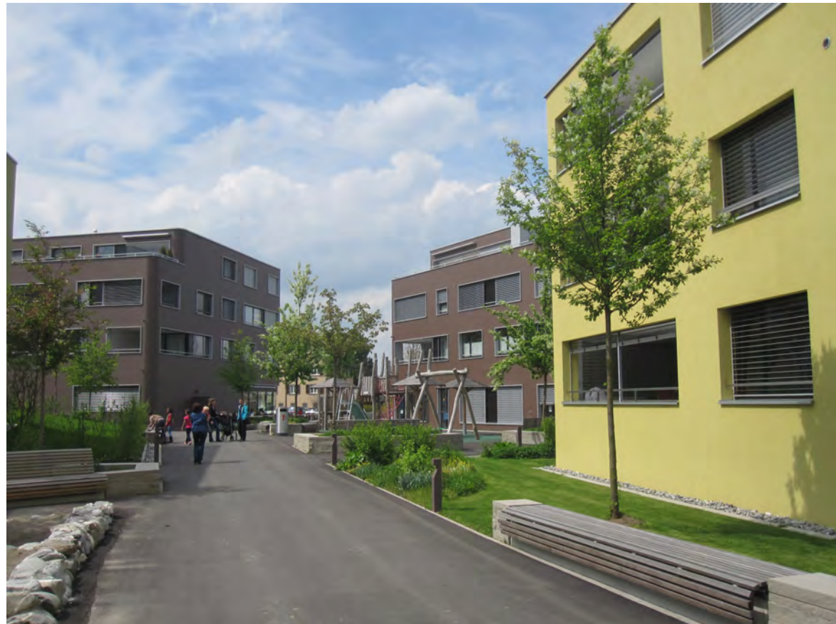
Zentrumsüberbauung Samstagern, Richterswil
