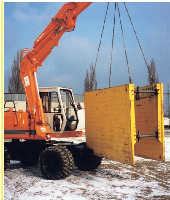
Il box di blindaggio già montato viene posato nello scavo finito.
