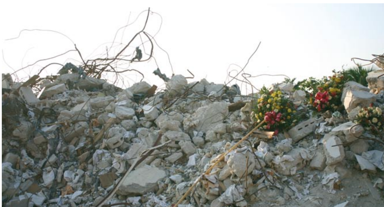
El derrumbe de la Facultad de Lingüística Aplicada (FLA). 300 muertos.
