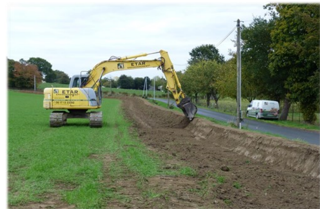
Déplacement d'une entrée de champ en partie haute d'une parcelle (en haut) et aménagement d'une haie sur talus (en bas) (Dinan Agglomération).
