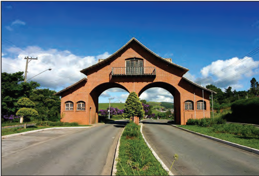
O Portal Artístico Prefeito José Rodrigues Feital Filho foi projetado pelo arquiteto Ailton dos Santos, em 1992. Marco da Recepção dos Turistas no Município, está instalado junto ao CITAC - Centro de Informações Turísticas, Artesanais e Culturais de Salesópolis
