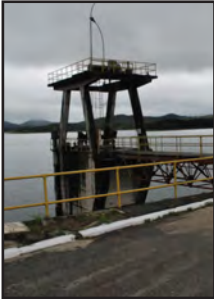
Barragem de Ponte Nova
