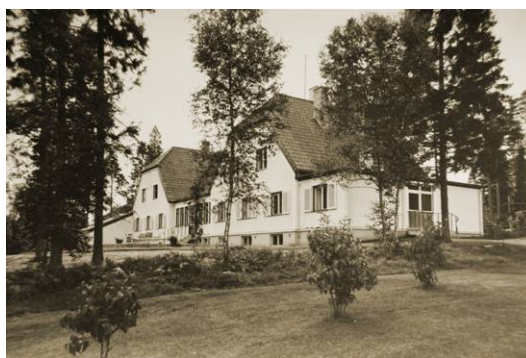
Nya personalbostäder byggda 1952, på norra sidan av huvudbyggnaden. Fotografi Sävsjö Sanatoriums arkiv.
