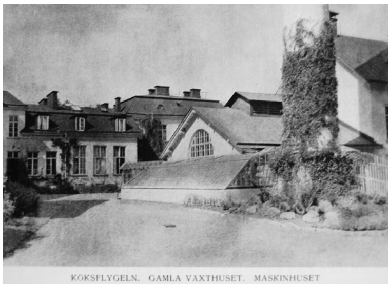
Växthuset. Notera hur basen av skorstenens täcks med klättrande grönska, samt de stenomgärdade rabatterna vid skorstenens fot. Vykort från tidigt 1900-tal, Bengt Petterssons samling.
