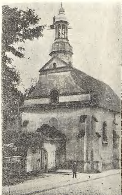
Kaplica Zboru w Głubczycach na zewnątrz
