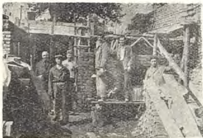
Zdjęcie z budowy kaplicy Zboru w Żywcu
