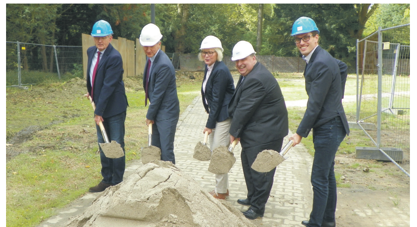
Setzen die ersten Spatenstiche (v.l.): Michael Graw, Städtische Seniorenheime, Oberbürgermeister Frank Baranowski, Margret Schneegans, Aufsichtsrat GGW, Harald Förster, Geschäftsführer GGW, und Ingo Bücker, Bauunternehmer.
