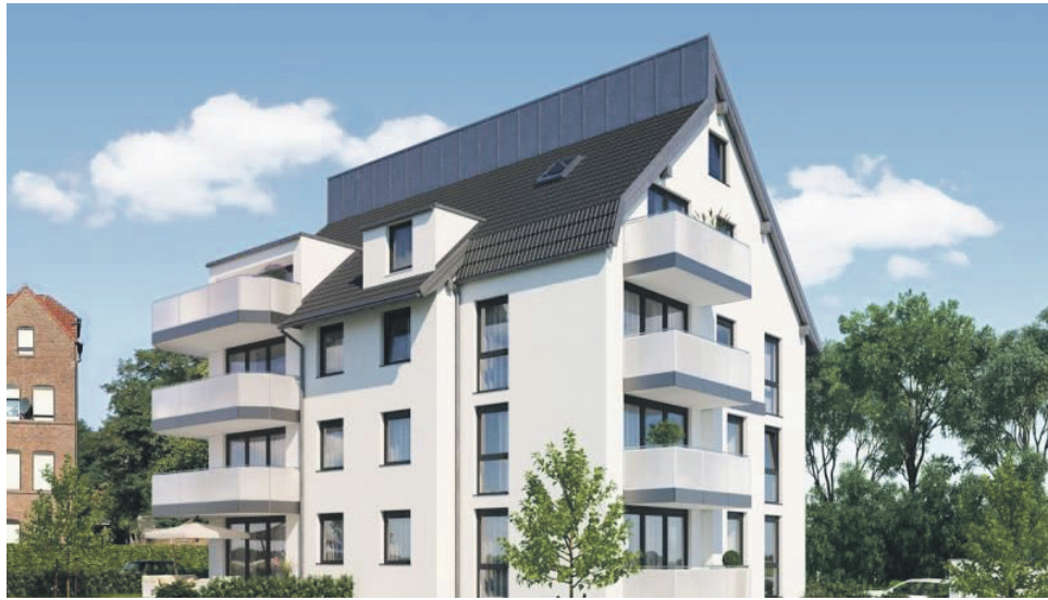
Das Mehrfamilienhaus mit neun Einheiten entsteht an der Achternbergstraße 17.
