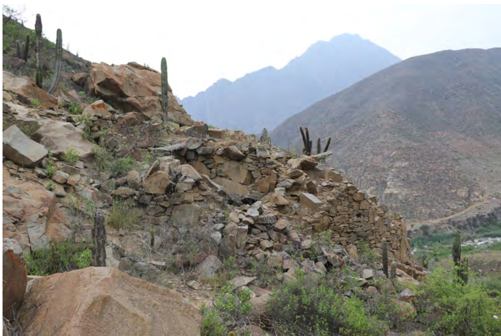
Fig. 12. Vista del área donde se concentran las estructuras de carácter funerario “chullpa”.
