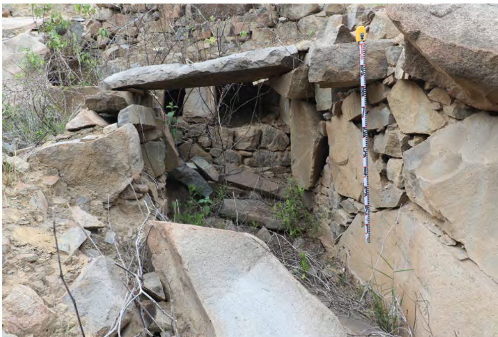
Fig. 13. Detalle de las estructuras de carácter funerario “chullpa”.
