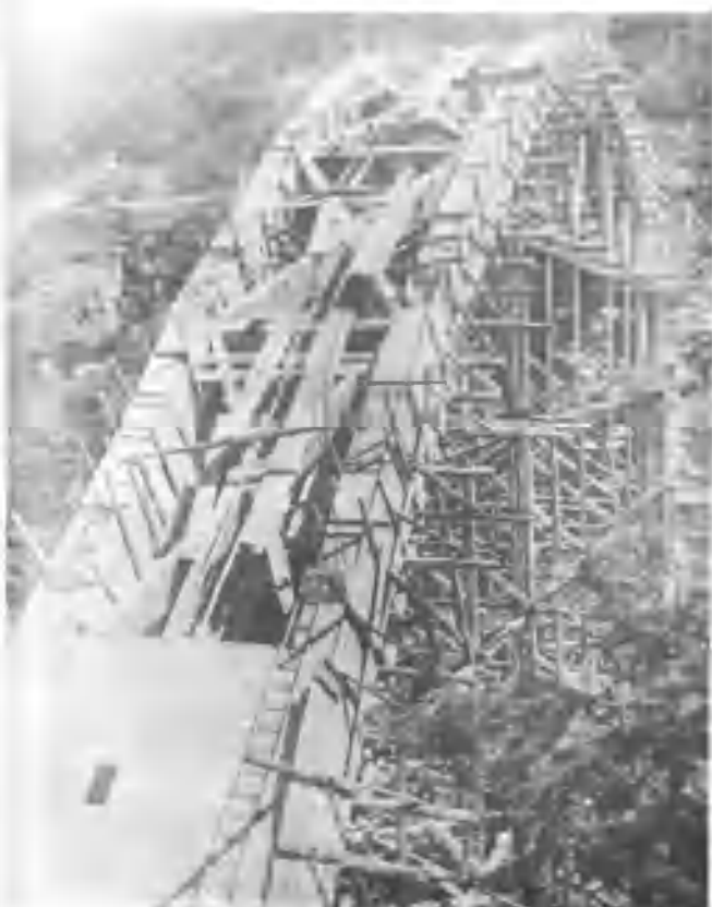
3. Il castello dell'armatura con già ultimato il viadotto del versante destro (visto da sud-ovest).
