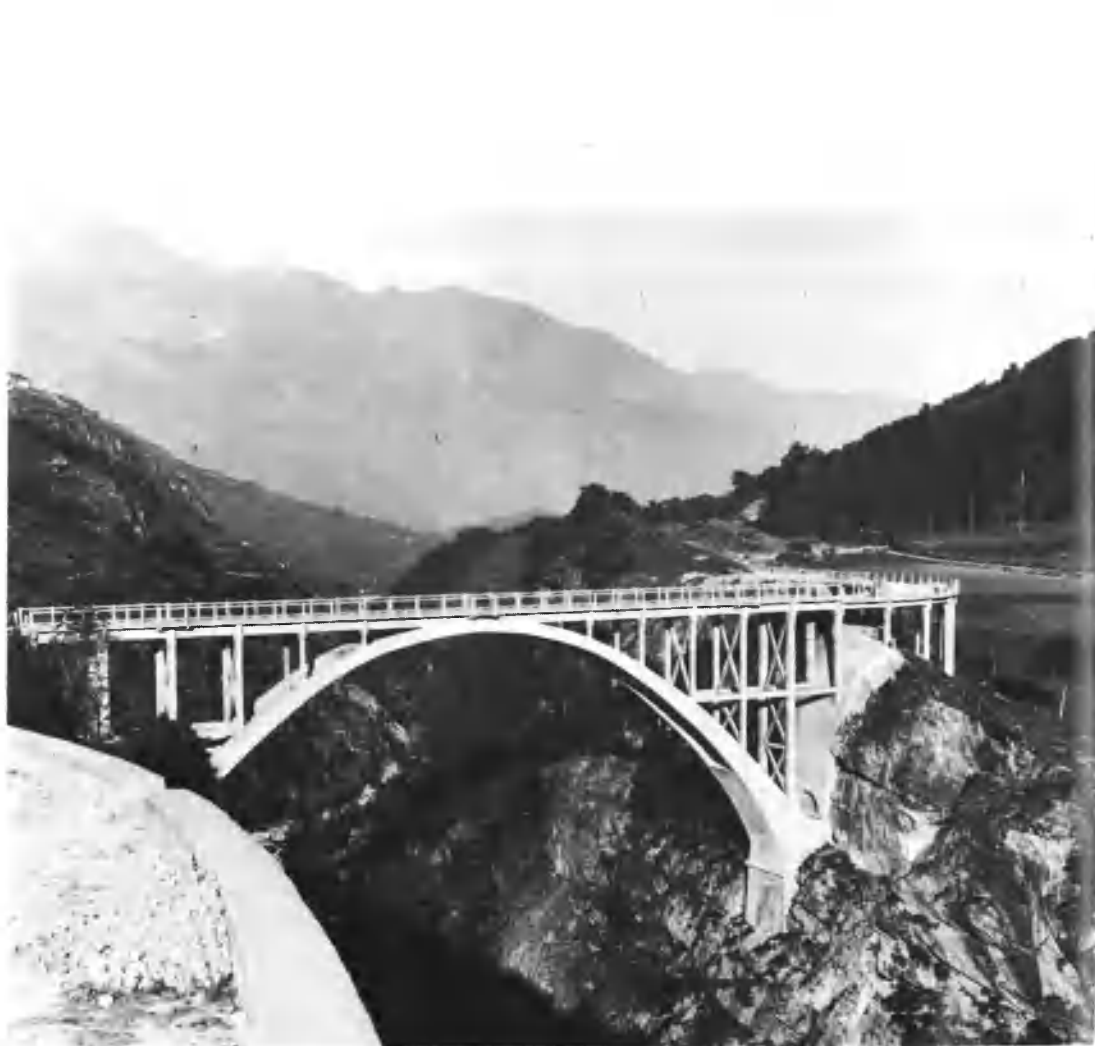
8. Il ponte visto da ovest: a sinistra in basso il piano viabile della nuova strada con un mucchio di materiale da pavimentazione allora in uso. (Macadam)
