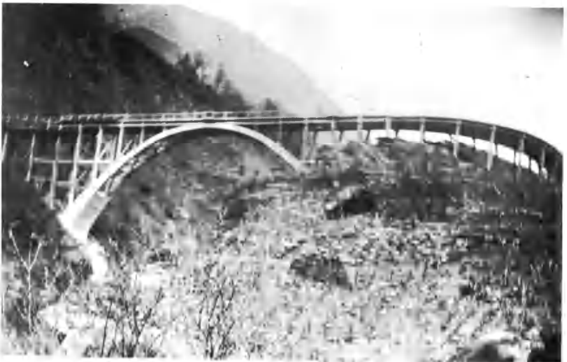
6. Il viadotto di raccordo del versante destro.
