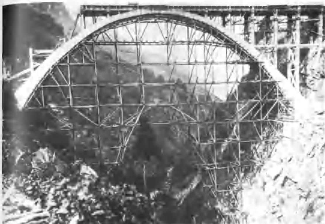
3. Il castello dell'armatura con già ultimato il viadotto del versante destro (visto da sud-ovest).
