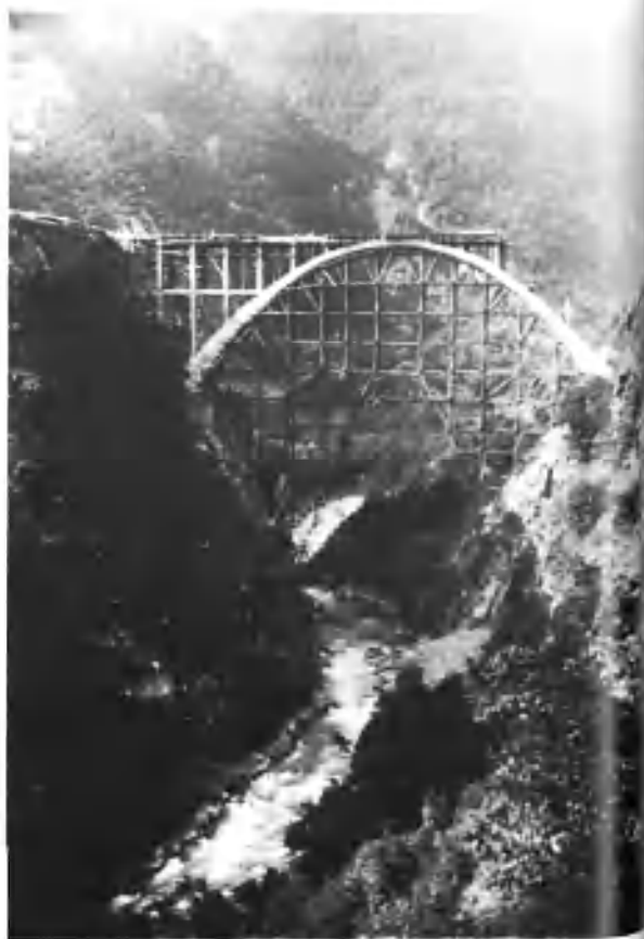
2. Il castello dell'armatura visto da nord-est.
