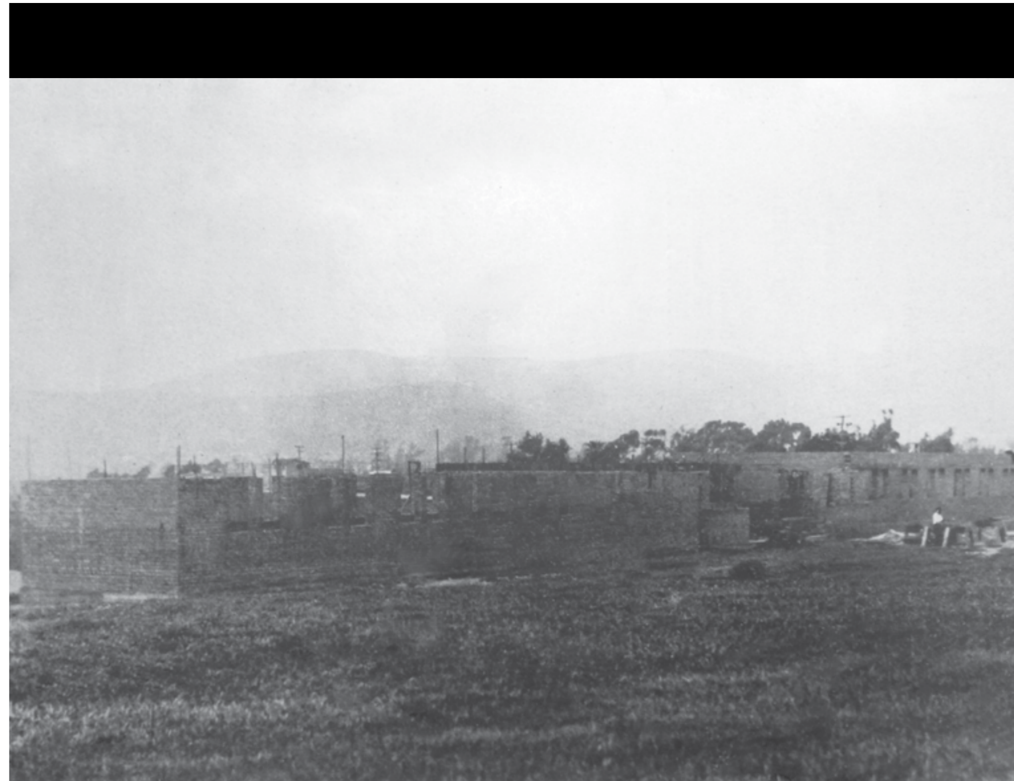
Construcción del cuartel de Infantería de Marina en Ensenada, Baja California, que posteriormente sería sede de la Compañía de Infantería de Marina Núm. 7
