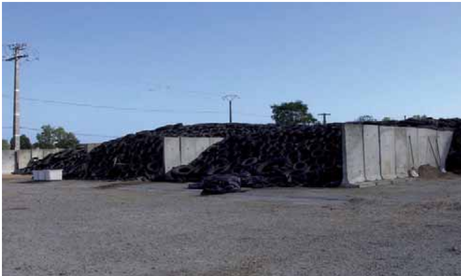
IV.3.-Batería de silos trinchera construidos con paneles laterales portátiles
