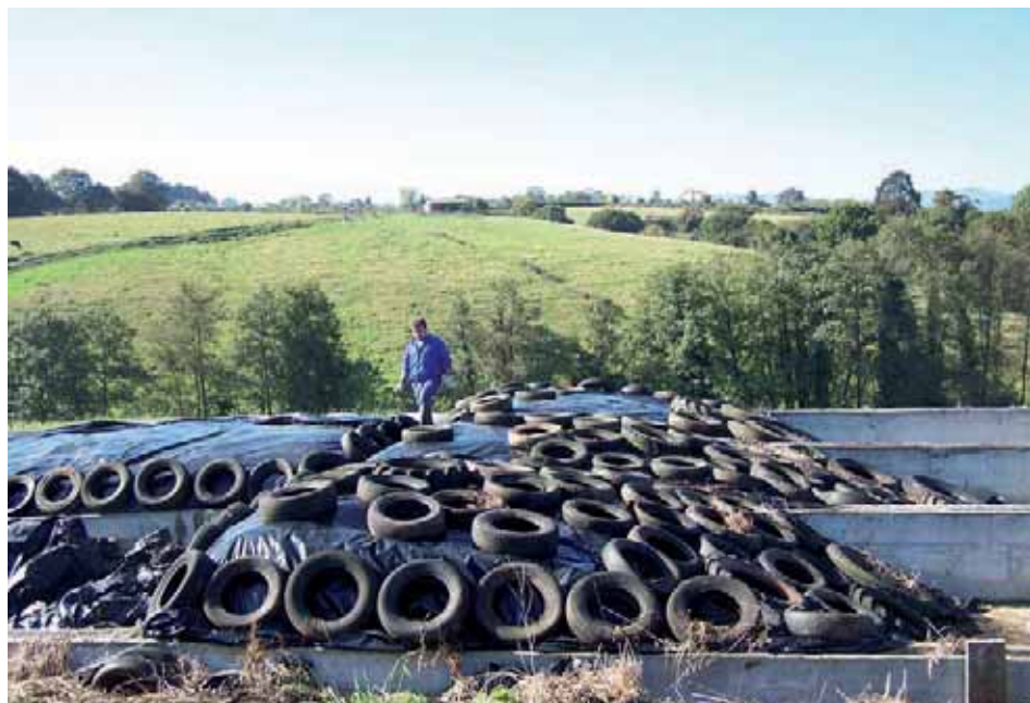
IV.1.-Batería de silos trinchera
