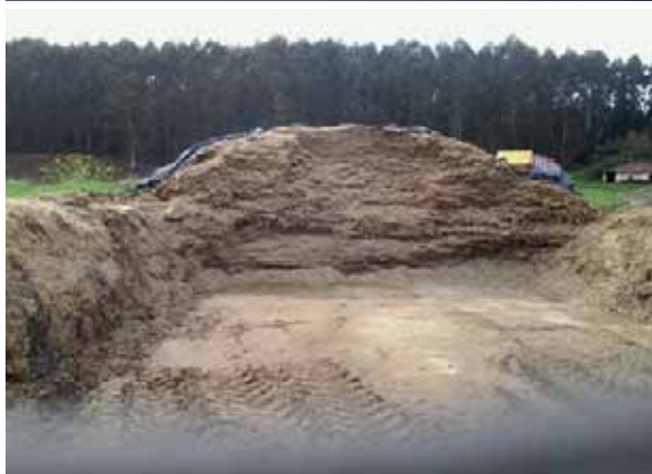
IV.4(a, b).- Silos zanja contruidos aprovechando los desniveles del terreno
