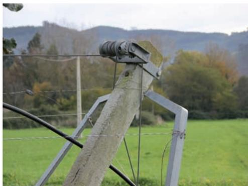
**56.** Poste de cabecera de línea inclinado a 45°, para mayor resistencia, con buen tensor para cable principal.
