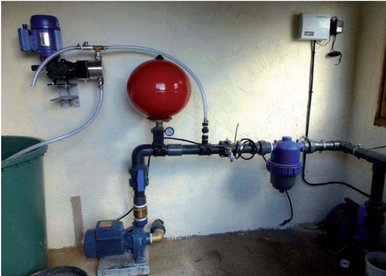
80. Cabezal de riego y fertirrigación.
