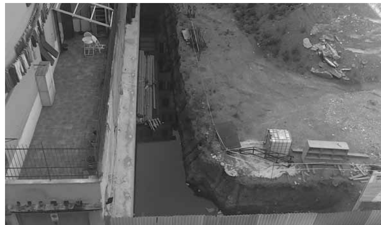
Il cantiere di via Armirotti nel 2014
