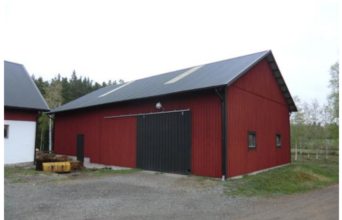
Uppfört 1999 på gjuten platt med stomme av trä under plåtbeklätt tak med ljusinsläpp. El finns.
