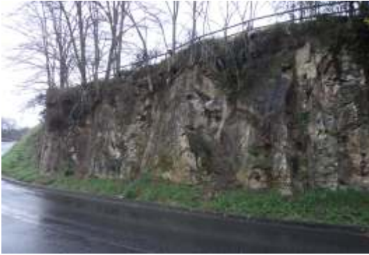
Afloramiento de granito de dos micas en los taludes anexos a la Fábrica de la Luz.
