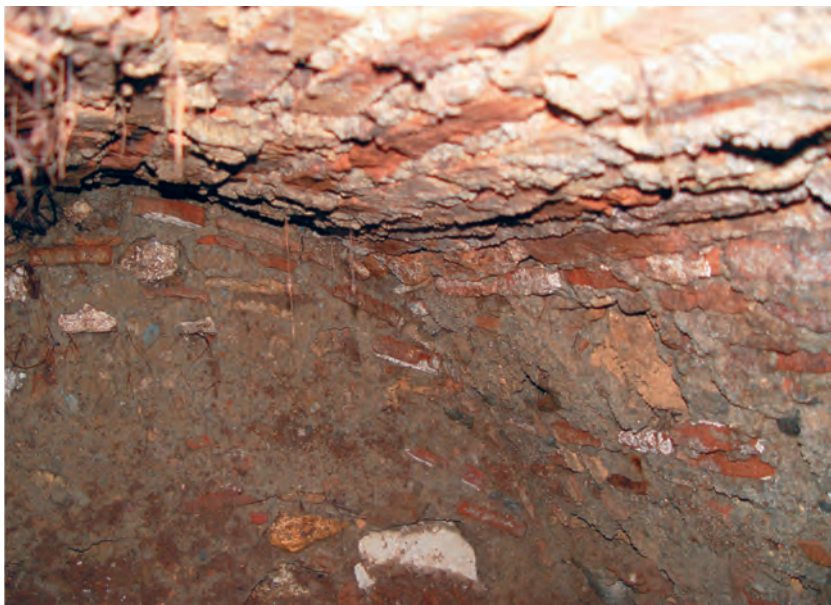
Fig. 15. Interno di uno degli ossari: particolare della volta in ricorsi di mattoni e malta. Soprintendenza BB.CC.AA. Messina, archivio U.O. X
