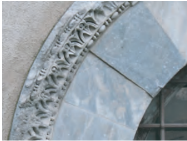
Figg. 26. Chiesa della SS. Annunziata dei Catalani, particolare dell'archivolto del portale destro del prospetto principale
