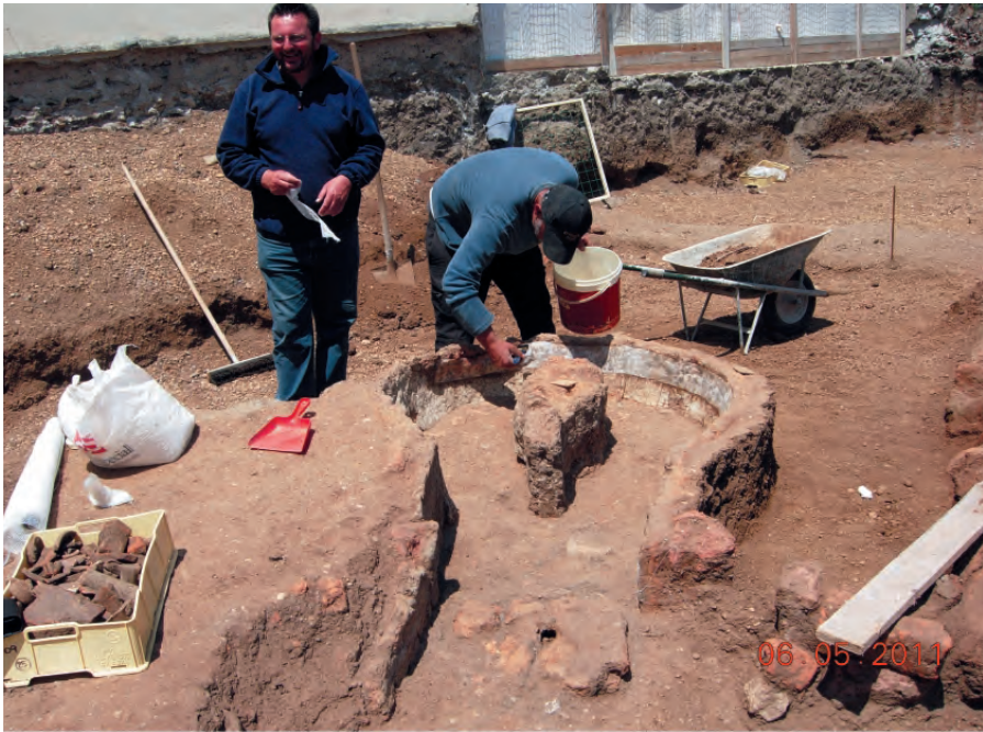
Fig. 33. Milazzo. Via Cosenz, interventi di consolidamento funzionali al recupero della struttura produttiva
