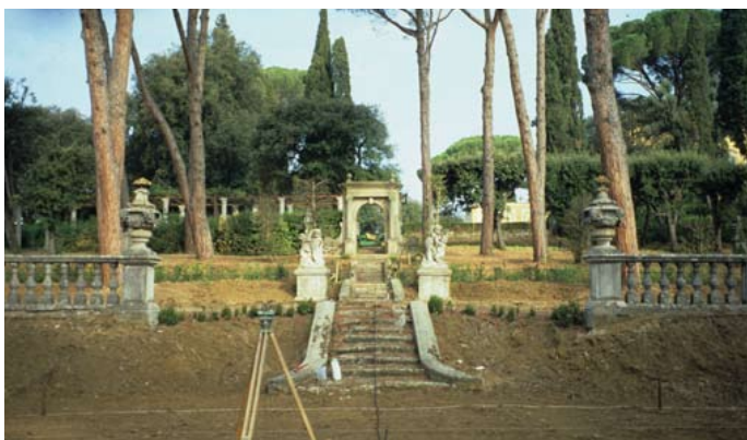
Fig. 2. Inizio dell'intervento, lavori su quote ed infrastrutture.
