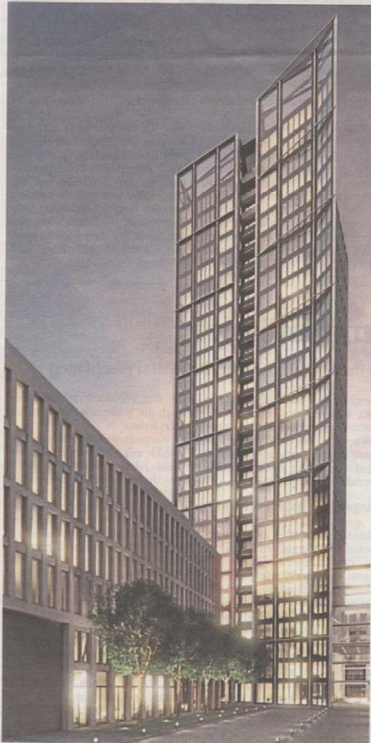
So soll der Turm 2017 das Viertel überragen.
