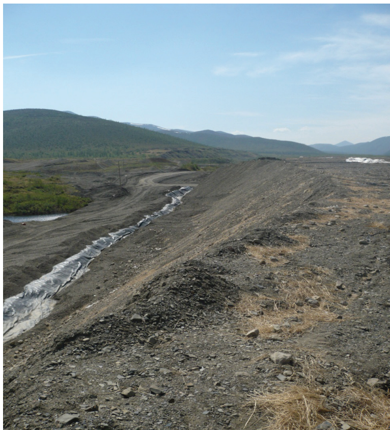
Рис. Вид рудного штабеля узла кучного выщелачивания с собирающим каналом
