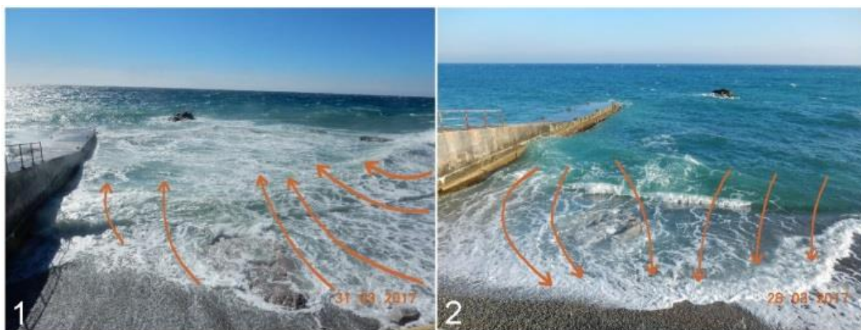
Рис. 6. Фото межбунного промежутка при восточном (1) и западном (2) ветро-волновом режиме на наблюдаемом участке берегоукрепительных сооружений. Стрелками показано направление переноса пляжеформирующих материалов
