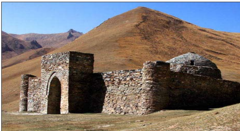
Рис. 1. Каменное сооружение Таш-Рабат.
