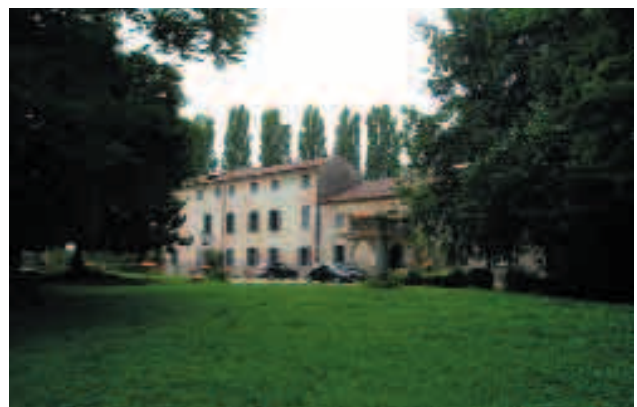
Fig. 1 - Veduta della facciata di Villa Brusoni-Scalella (Sambruson di Dolo).
