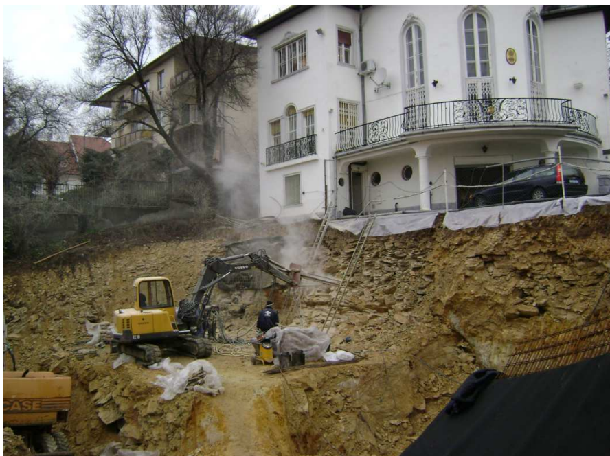
4. kép (Budapest, Búzavirág u.: munkagödör megtámasztás, kivitelező: Sycons Kft.)
