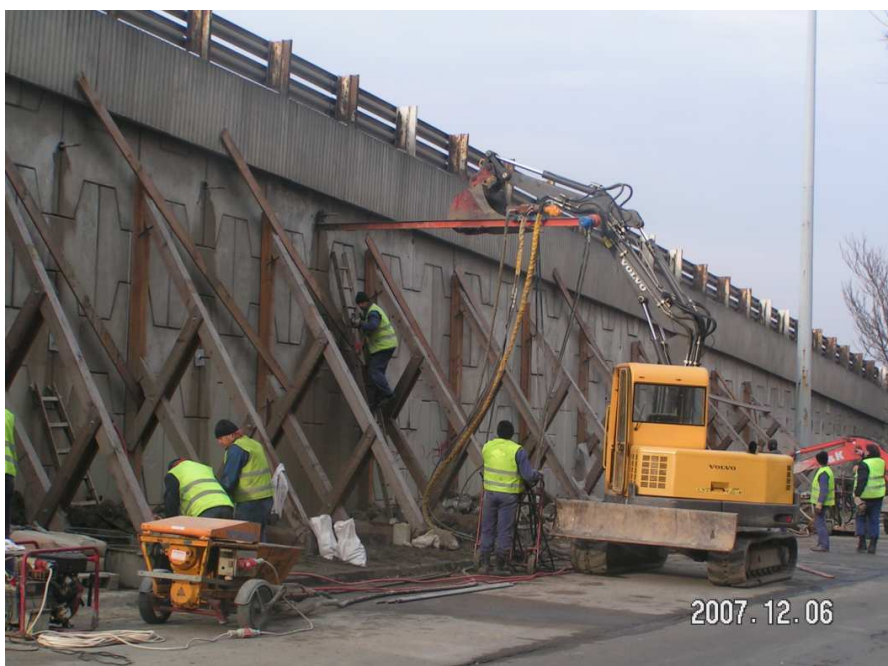
3. kép (Budapest, Helsinki út: támfal, kivitelező: Sycons Kft.)
