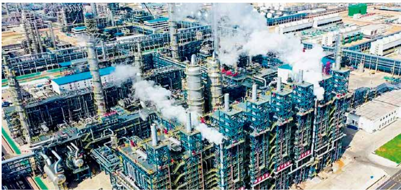
11月20日，寰球工程公司承担的广东石化120万吨/年乙烯装置8台裂解炉烘炉工作全部完成，乙烯裂解炉正式具备投料开车条件。
