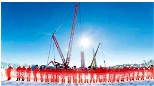
11月16日，中国石油工程建设公司负责施工的吉林油田15万千瓦风光发电项目乾清3号风机第一节塔筒顺利安装就位，标志着中石油首个风电项目首台风机顺利开吊。该项目是吉林油田在建15万千瓦自消纳风光电项目重要组成部分，预计年末可并网发电，届时，吉林油田电力自消纳清洁替代将取得实质性进展。
