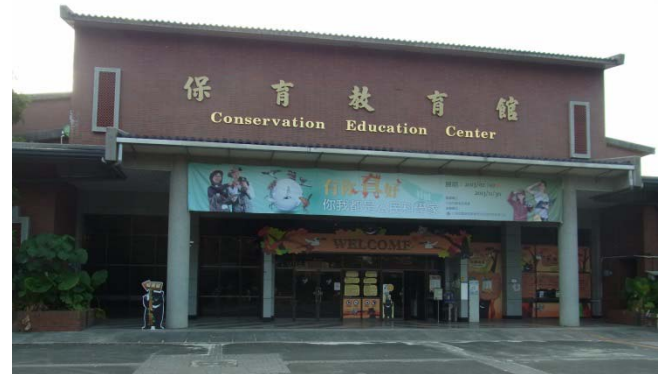
写真1. 室内展示施設の入口。
