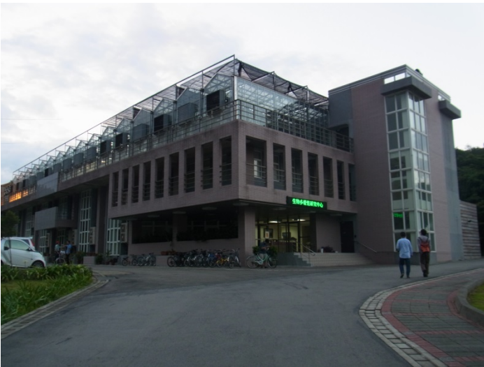
写真1. 二階建物の上に設置された実験温室。
