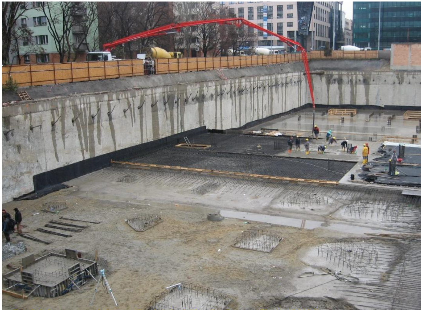
Bp. Váci út: Hátrahorgonyzott résfal
