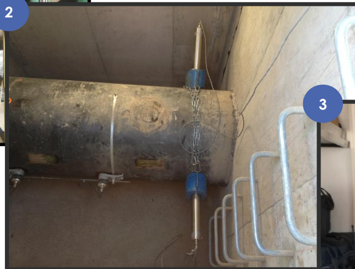
Detector instalado en ducto
