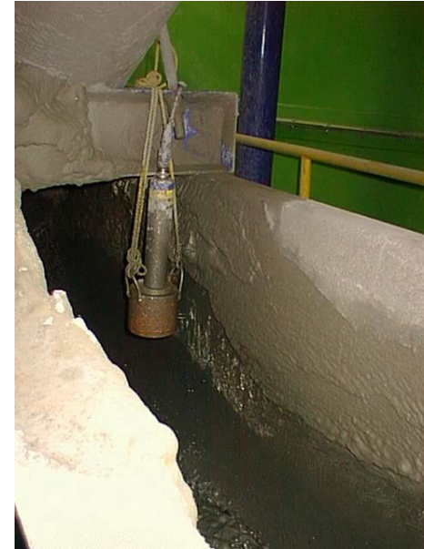
Detector en canaleta de concentrado
