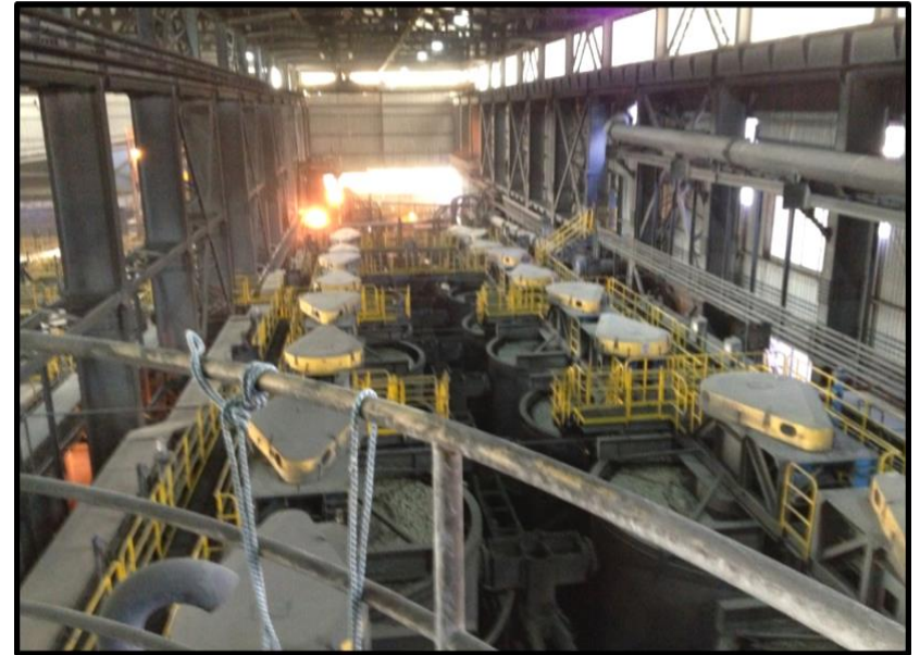
Vista global del Circuito de Flotación Scavenger interior
