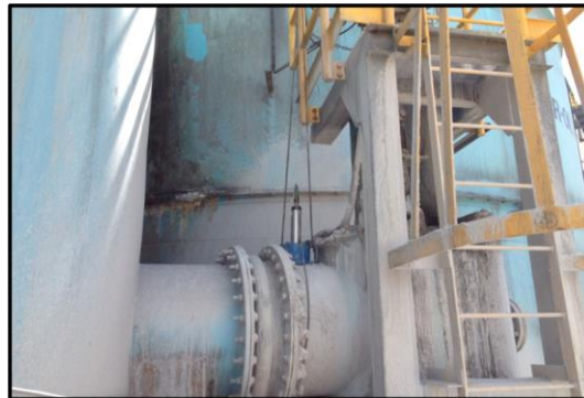
Detector Traspaso entre Celdas
