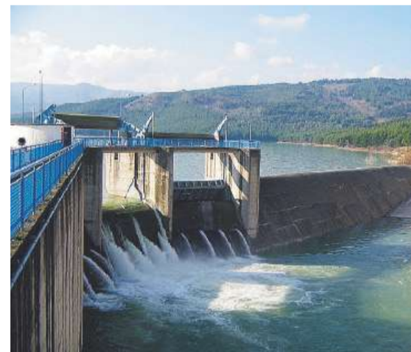
OCCHITO Una foto d'archivio della diga nel Foggiano
